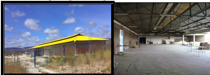
Galpão Localizado em Nova Olinda (CE) Foto: Equipe Técnica do CETEM, 2007
