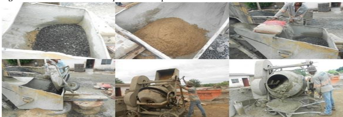
Figura 4: Processo de transformação da matéria prima em concreto.
